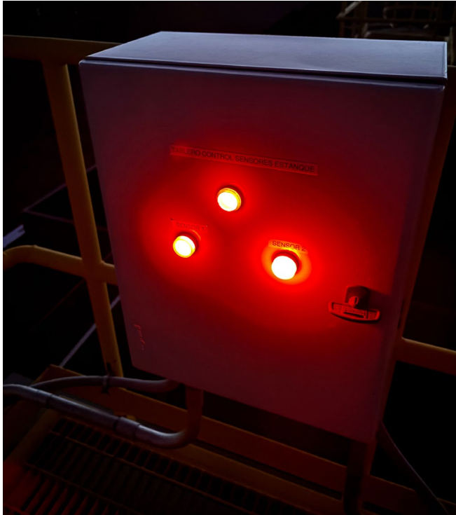
Fig. 16. Arriba: Luces piloto de tableros existentes en Observatorio Simons. Abajo: Efectos de las luces piloto rojas en tablero cercano a antena en el futuro sitio del GMT. En imágenes de media exposición se aprecia su acción lumínica. Sector contiguo a donde la OPCC realiza mediciones de calidad del cielo.
