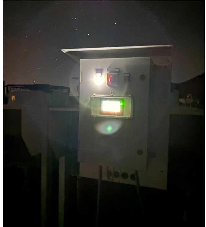
Fig. 16. Arriba: Luces piloto de tableros existentes en Observatorio Simons. Abajo: Efectos de las luces piloto rojas en tablero cercano a antena en el futuro sitio del GMT. En imágenes de media exposición se aprecia su acción lumínica. Sector contiguo a donde la OPCC realiza mediciones de calidad del cielo.
